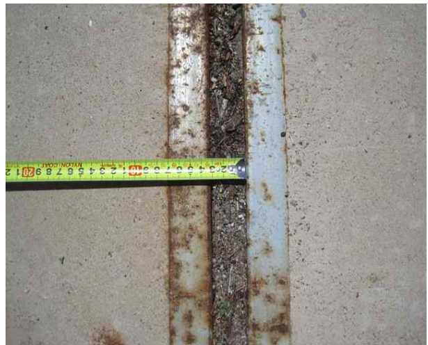
신축이음 유간 측정
