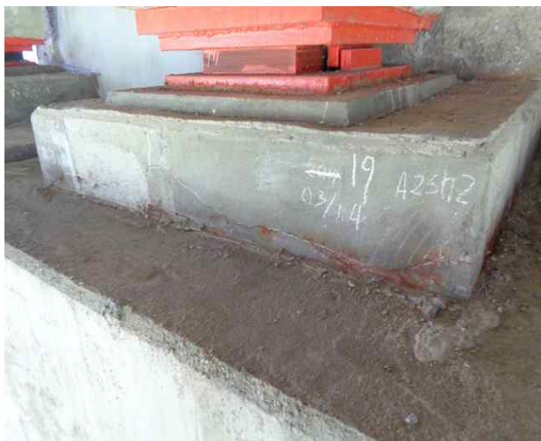
받침장치 05 A2 SH2 받침콘크리트 균열 (cw=0.3mm)
