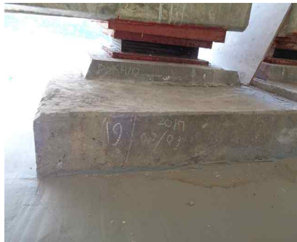
받침장치 13 P2 SH4 받침콘크리트 균열 (cw=0.2mm)
