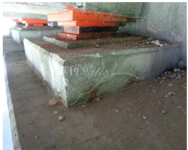
받침장치 06 A2 SH3 받침콘크리트 균열 (cw=0.3mm)
