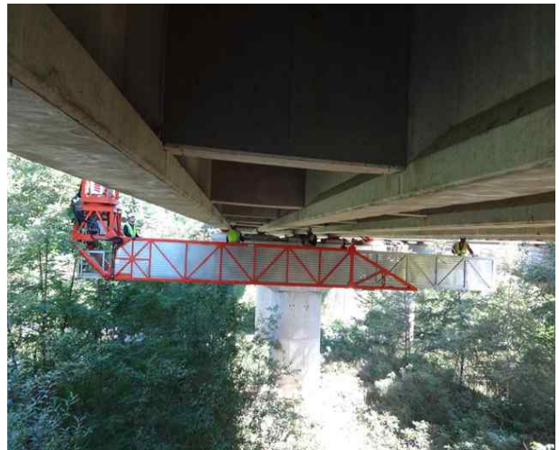
교량점검차를 이용한 근접조사
